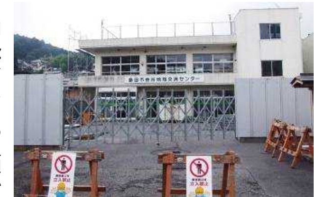
工事用の仮囲いがされた交流センター
